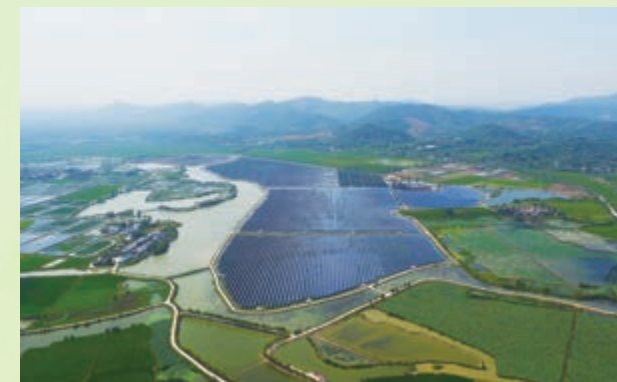
Fanchang Solar Farm 繁昌光伏電站
