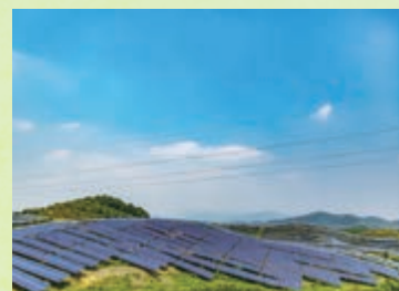
Hong'an Solar Farm 紅安光伏電站
